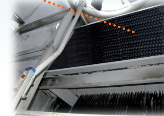
DriAir™ Eliminators - Eurovent Certified Separatori di gocce DriAir™ - Certificazione Eurovent Éliminateurs de gouttes DriAir™ - Certifié Eurovent DriAir™ Tropfenabscheider - Eurovent zertifiziert
